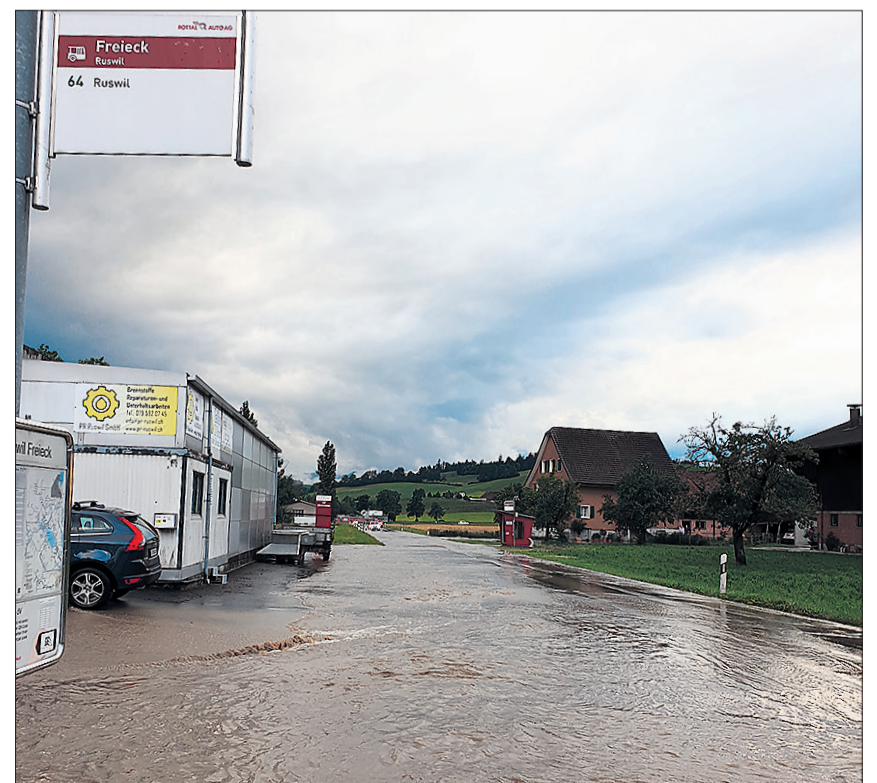
Der Bielbach trat im Gebiet Freieck/Lein über die Ufer und flutete Keller und die Kantonsstrasse. Foto Feuerwehr Ruswil
