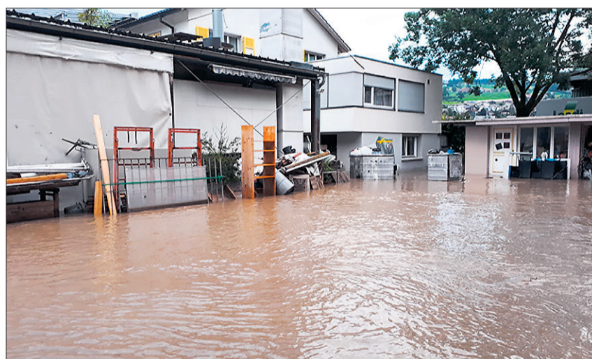
Blick auf das überflutete Firmenareal von Pascal Günter, Spritzwerk AG/Malergeschäft GmbH. Foto zVg
