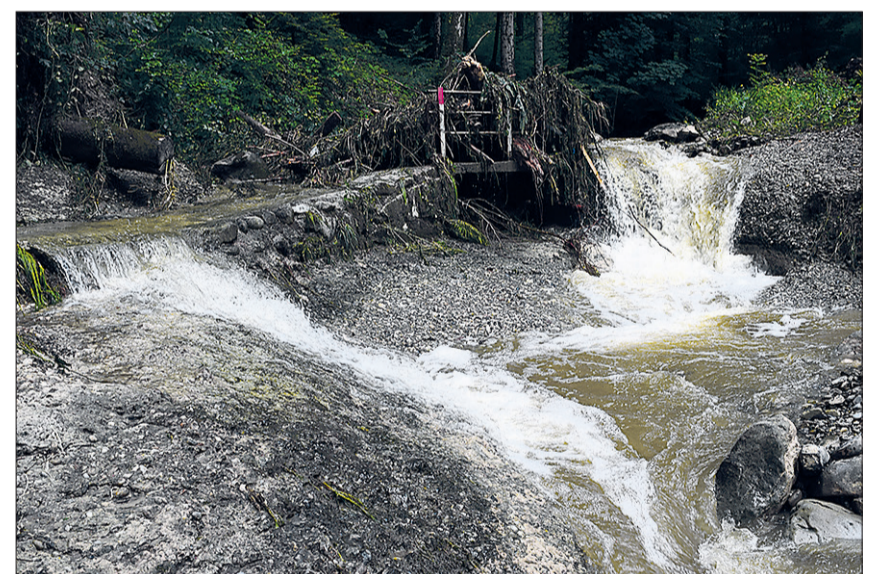
Der Stäubligbach überflutete das Wanderwegbrüggli bei der Grütweid. Der Wanderweg ist gesperrt. Foto Ferdinand Brühlmann
